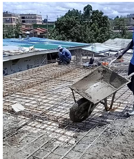
Stavba nové střechy
